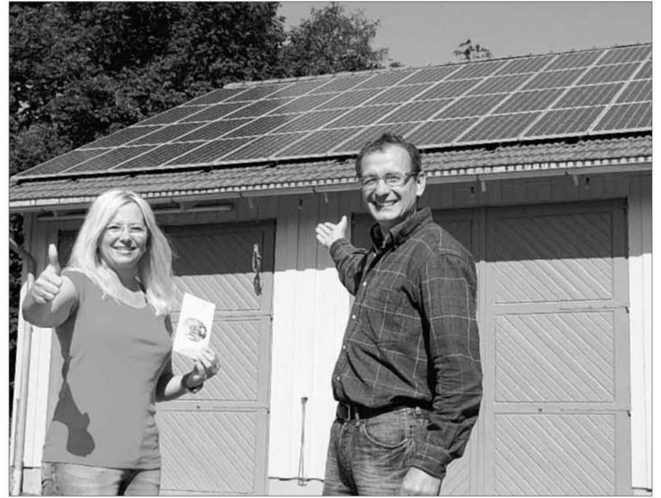
Auch der Bauhof hat schon eine Photovoltaikanlage auf dem Dach. Fotos (2): Notz
