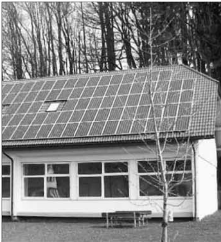
Photovoltaikanlage auf dem Bürgerhaus in Winterstetten. Foto: oh
