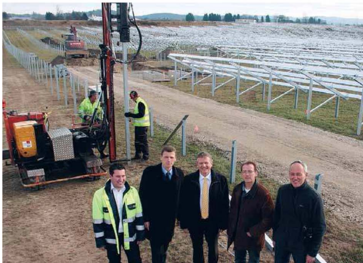
Während neue Pfosten für die Unterkonstruktionen in den Boden gerammt werden, freuen sich über den zügigen Baufortschritt (von links): EnBW-Projektleiter Christian Neudert, Hartmut Reck, Leiter des EnBW-Regionalzentrums Oberschwaben, OB Hans-Jörg Henle, Berthold König und Michael Krumböck.
